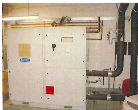
Obrázek 11 – kompresorové chlazení – lokální
