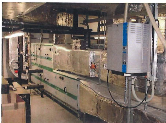
Obrázek 6 – strojovna VZT, split (multi-split) klimatizace
