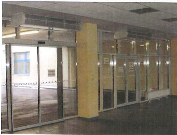
Obrázek 7 – vzduchové clony u vstupů do pavilonů
