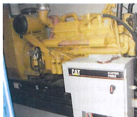
Obrázek 12 – záložní zdroj, SO 06, dieselagregát CAT 3412 CT
