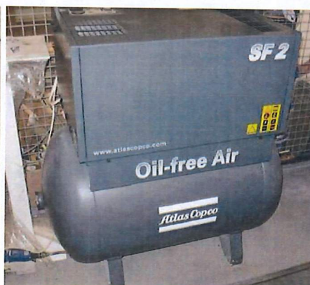
Obrázek 8 – kompresorová stanice, kompresory Atlas Copco / strojovna VZT, kompresor Atlas Copco, typ SF2
