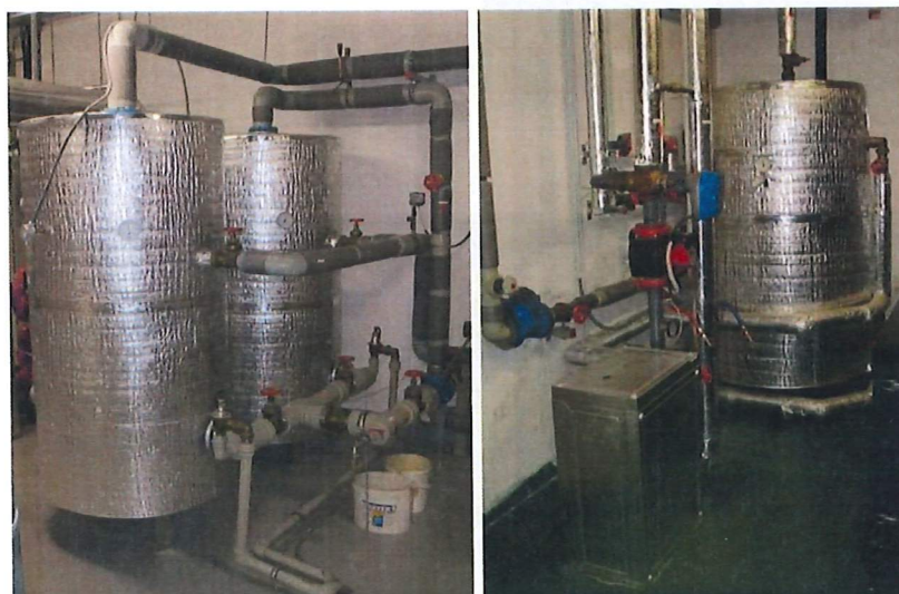
Obrázek 5 – příprava TV, akumulační nádoby
