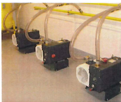
Obrázek 9 – vakuová stanice, SO 06, vývěvy EVISA E 150
