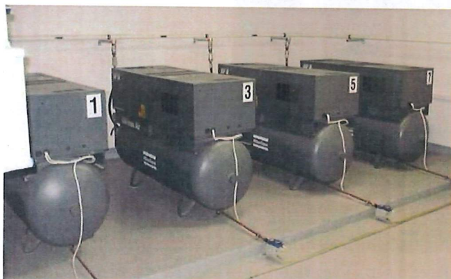
Obrázek 8 – kompresorová stanice, kompresory Atlas Copco / strojovna VZT, kompresor Atlas Copco, typ SF2
